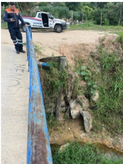
Vistoria em Passarela
