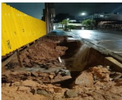
Rompimento da rede de água e colapso da calçada
