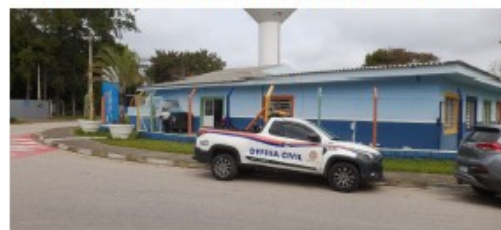
Vistoria Estrutural Preventiva em E.M.
