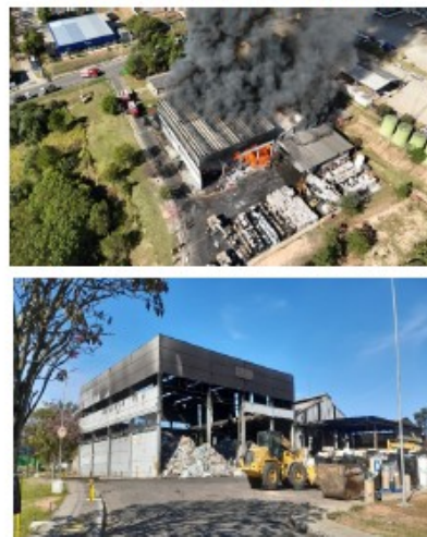
Incêndio em Planta Industrial
